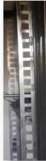
الشكل (3) السكة الحديدية ذات الثقوب المتسلسلة لتثبيت توقف الحركة (حيدر، 2023: ص9)
